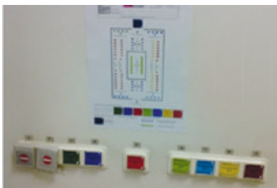
Инструкция на стене
